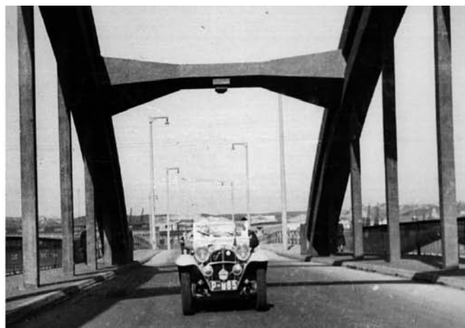
Na mostě ve Gdyni
